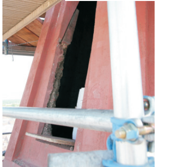
Beim Wiederaufbau bis 1949 musste der obere Teil des Helmes aus Stahlträgern und Beton neu gefertigt werden.
