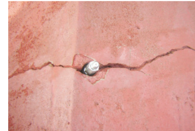
In die Löcher werden dann Verpressanker gesetzt.
