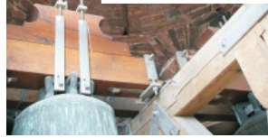
Hier ein Blick vom Glockenstuhl aus auf die Zwischendecke zum Turmhelm. Diese ist mittlerweile von unten abgestützt. Zukünftig wird der Helm vom Glockenstuhl aus begehbar sein.
