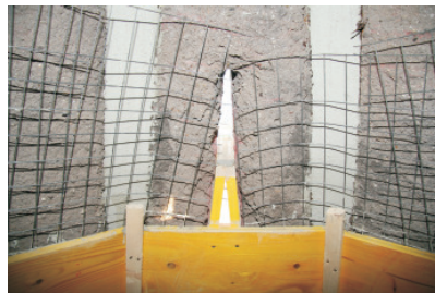
Die freigelegten Betonträger werden entrostet und mit Rostschutzfarbe beschichtet.
