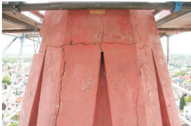
Beim Vergleich mit dem oberen Bild kann man gut erkennen, wie die rostenden Stahlträger im Inneren des Betons diesen im Lauf der Jahre gesprengt haben.
