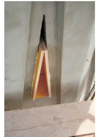
Von außen werden in regelmäßigen Abständen Löcher in den Beton gebohrt.
