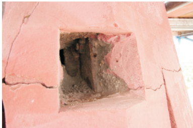
Hier wurde ein Probeschnitt in den Beton gemacht. Man kann einen der rostigen Stahlträger gut erkennen. Ebenfalls gut sichtbar ist der rot gefärbte, gerissene Beton, der die Außenhaut des Helmes bildet. Der sog. Stampfbeton im Inneren ist so stark durch Feuchtigkeit zersetzt worden, dass dieser nicht aufreißen konnte.
