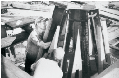
Beim Wiederaufbau bis 1949 musste der obere Teil des Helmes aus Stahlträgern und Beton neu gefertigt werden.
