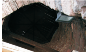
Hier ein Blick vom Glockenstuhl aus auf die Zwischendecke zum Turmhelm. Diese ist mittlerweile von unten abgestützt. Zukünftig wird der Helm vom Glockenstuhl aus begehbar sein.
