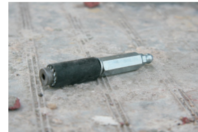
Durch diese wird in alle Risse 2-Komponenten-Epoxyharz gespritzt. Dieser läuft auch in feinste Haarrisse und verschließt diese nach dem Aushärten luftdicht.
