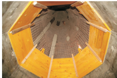
Der zersetzte Beton wird nun abschnittsweise herausgekratzt, der Turm eingeschalt und mit einem hochfesten Beton ausgegossen. Zur Stabilisierung werden rostfreie Stahlmatten eingegossen.
