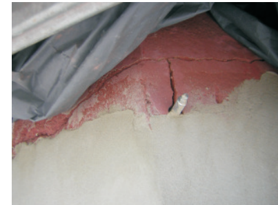
Zuvor wird der gesamte Turmhelm von außen mit Betonsaniermörtel versiegelt. So kann das Harz auch die äußeren Risse füllen und der Beton ist vor Witterungseinflüssen geschützt.
