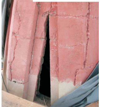
Hier wurde ein Probeschnitt in den Beton gemacht. Man kann einen der rostigen Stahlträger gut erkennen. Ebenfalls gut sichtbar ist der rot gefärbte, gerissene Beton, der die Außenhaut des Helmes bildet. Der sog. Stampfbeton im Inneren ist so stark durch Feuchtigkeit zersetzt worden, dass dieser nicht aufreißen konnte.
